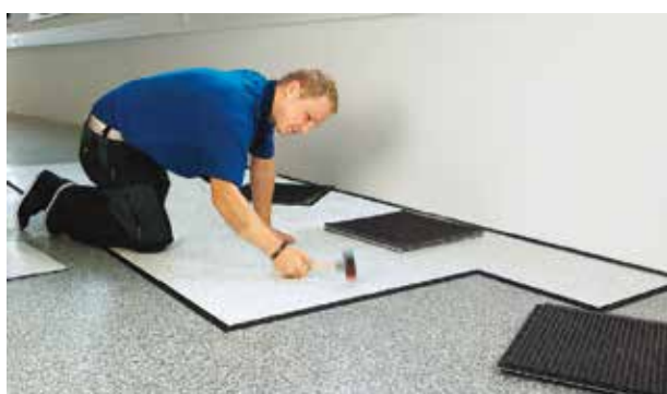
укладка при помощи молотка с мягкой головкой
