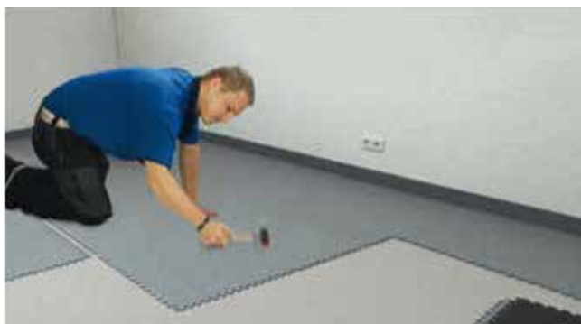
укладка при помощи молотка с мягкой головкой
