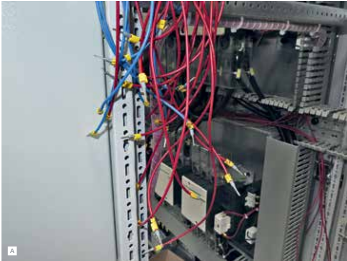
Эргономика электромонтажа: A – провода, подготовленные без участия автомата: наборная маркировка, обжаты вручную наконечники, случайное расположение в пучке; B – технологическая гирлянда, подготовленная бандажной системой Zeta 633. Часть законцовок имеет неполную зачистку
