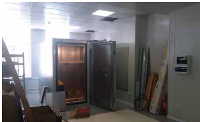
2 Камеры устанавливаются в новом отремонтированном помещении
