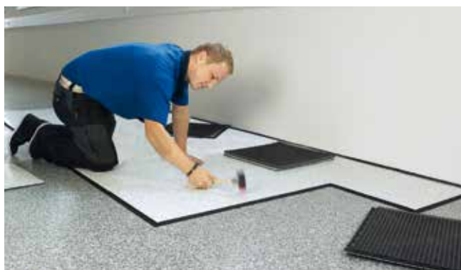
укладка при помощи молотка с мягкой головкой
