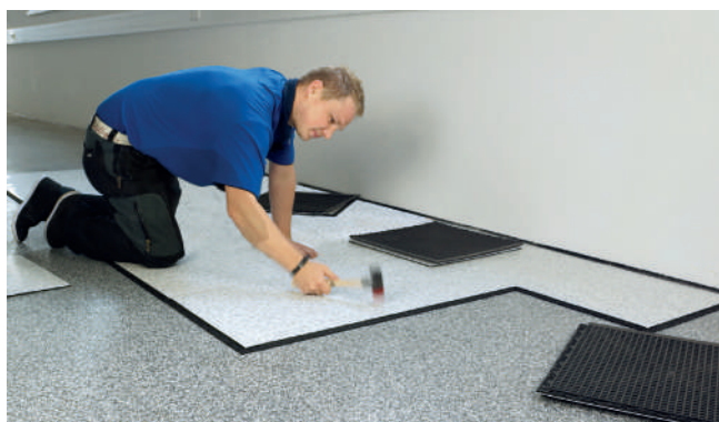
укладка при помощи молотка с мягкой головкой
