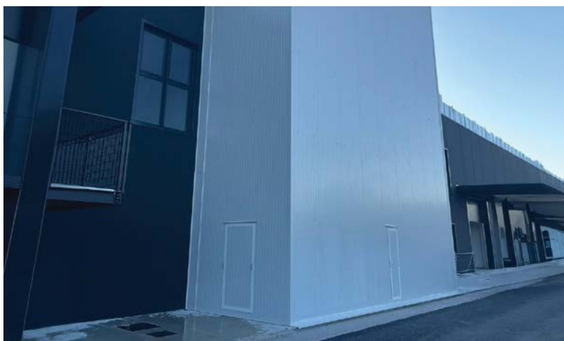
Изолированная самонесущая конструкция для наружной установки
