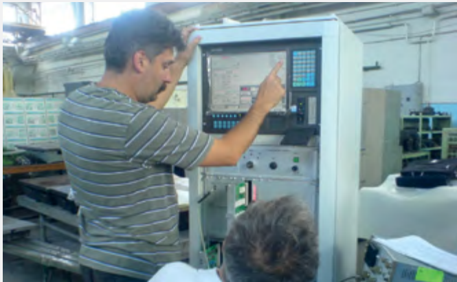
Монтаж и кроссировка блоков. Подключение и настройка систем.
