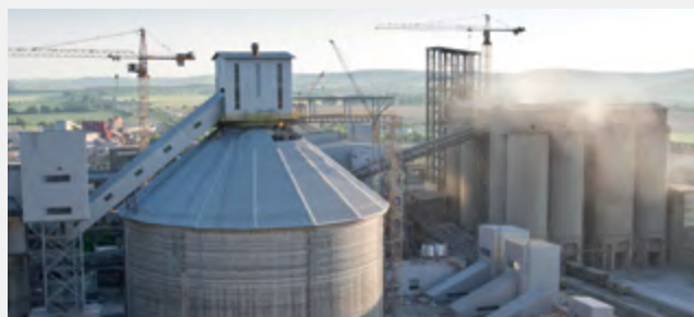
D8 ENDEAVOR Cement – цементная промышленность
