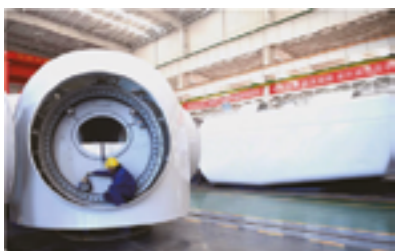
Монтаж ветроэнергетического оборудования
