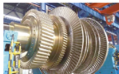
Монтаж устройства атомной энергии
