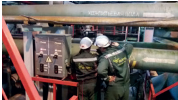
Специалисты отдела энергоконсалтинга устанавливают переносной расходомер на трубопровод ХПВ на ВОС
